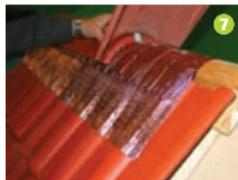
Ziegel aufsetzen und befestigen, bringt erforderliche Zusatz-Spannung.
