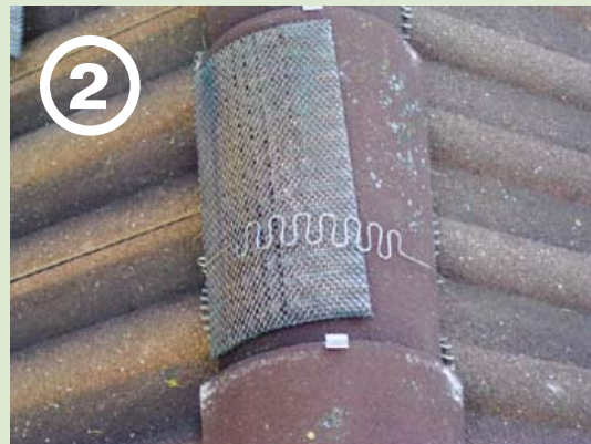
... erste Federklammer setzen ...
